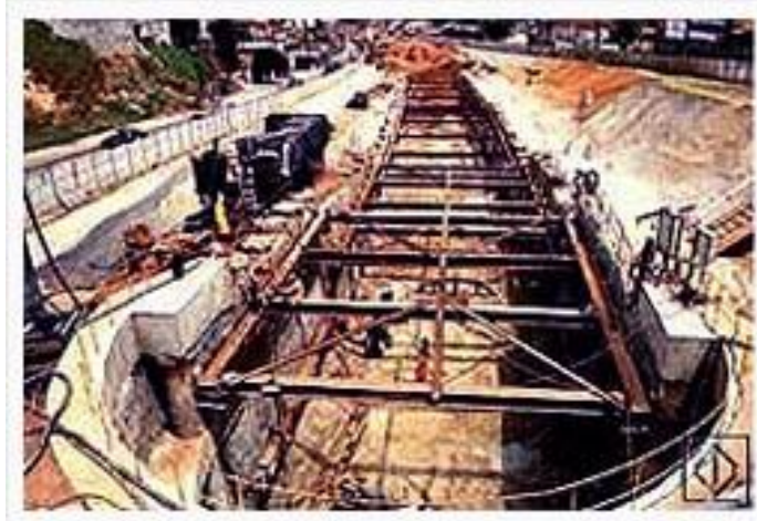
Figura 6. Construcción línea metro por método de trinchera.
