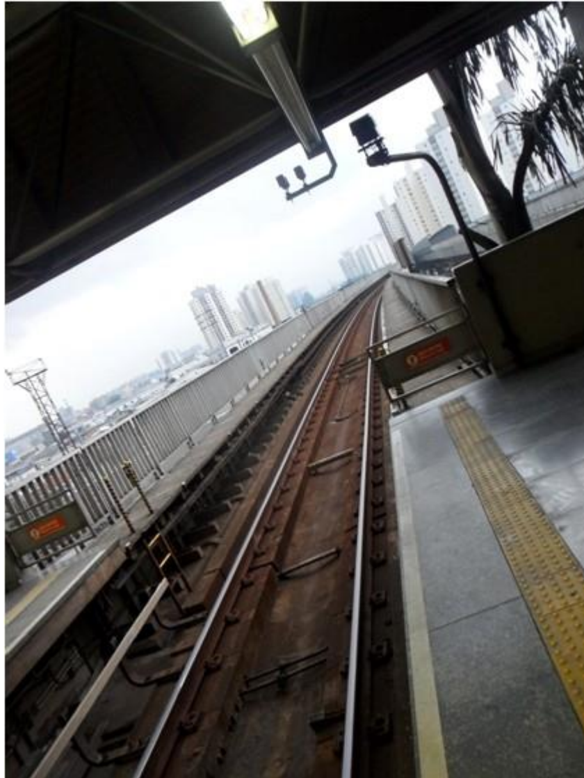
Figura 5. Línea elevada metro São Paulo.
