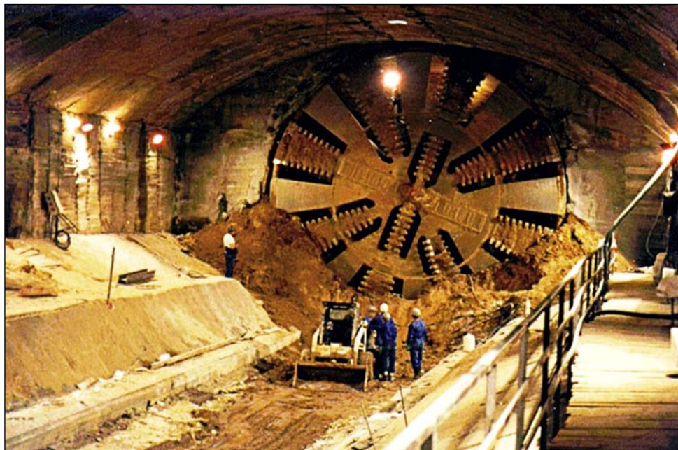
Figura 1. Tuneladora PLMB en obra.
