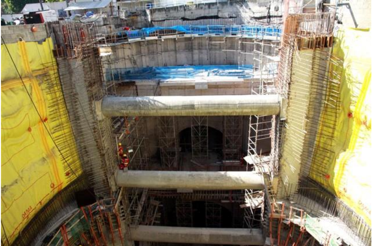
Figura 9. Proceso constructivo línea 4 São Paulo
