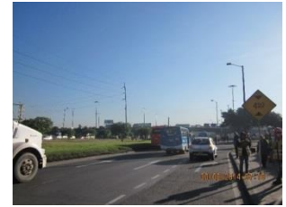
Fig. 5 Fotografía del acceso sur (Extraída por el autor del informe base de Cartilla de Monitoreo Tránsito y Transporte Urbano).
