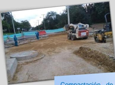
Compactación de la base con equipos de vibro compactadores y humectando el material pétreo.
