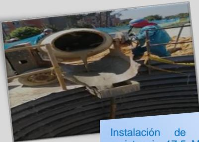
Instalación de concreto baja resistencia 17.5 MPA, para sellar vacíos entre terreno natural y laminas metálicas
