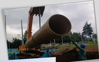
Suministro e instalación de la tubería GRP D=1.0m.
