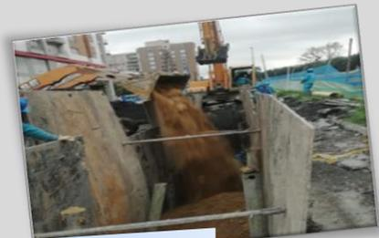
Relleno con material granular (Recebo) en capas según normas EAAB.
