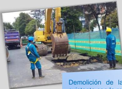
Demolición de la capa asfáltica existente con la retro excavadora.
