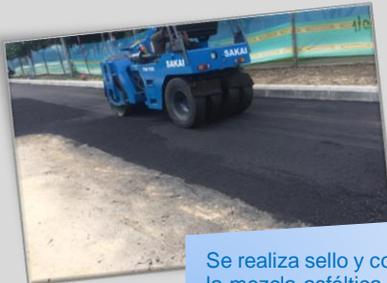
Se realiza sello y compactación de la mezcla asfáltica con equipos de llantas, dando terminados a la vía.
