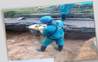
Compactación con equipo manual (tipo saltarín) en sectores de difícil acceso con vibrocompactador.
