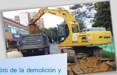
Cargue y retiro de la demolición y de la excavación en volquetas diferentes para que se han llevados a los centros de disposición autorizados.
