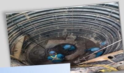
Demolición de interferencias en concreto (obras existentes canceladas por la EAAB-ESP).
