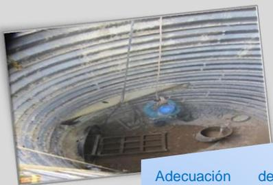
Adecuación de punto de lanzamiento para inicio de labores en Túnel Linner  $d=60''$ , para instalación de láminas metálicas sentido horizontal para instalación de tubería GRP para diámetros entre  $36''$  a  $40''$ .
