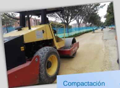
Compactación con equipo "Vibrocompactador" para darle la compactación adecuada a la subbase granular.
