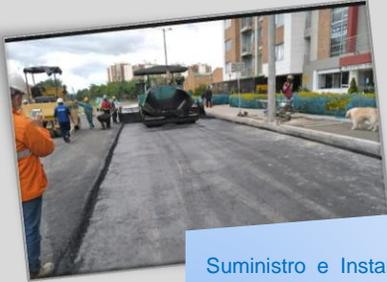
Suministro e Instalación de riego de liga para instalación de segunda capa de material asfáltico Md-19.
