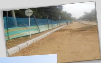
Compactación de la base con equipos de vibro compactadores y humectando el material pétreo.
