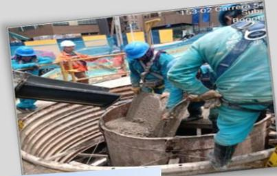
Construcción de cámara en concreto estructural en zona de pozo de cierre.
