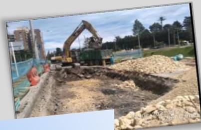
Recuperación de espacio público afectado por las excavaciones según norma IDU, para reconstrucción de caja de vía a tramos intervenidos.
