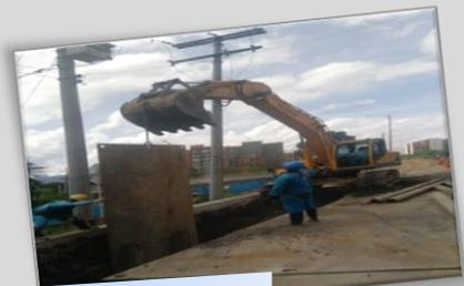
Instalación del entibado en láminas de acero a medida que se realiza la excavación mecánica.
