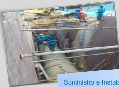
Suministro e Instalación de tubería de alcantarillado GRP incluye acoples en longitudes de 6.0 metros.
