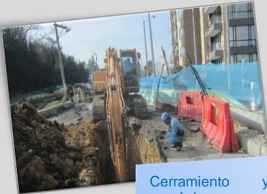
Cerramiento y excavación mecánica para construcción de pozo de lanzamiento.
