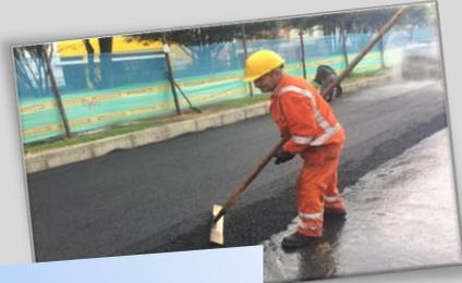
Conformación de material asfáltico para finalizar capa ultima de mezcla densa en caliente Md-19.
