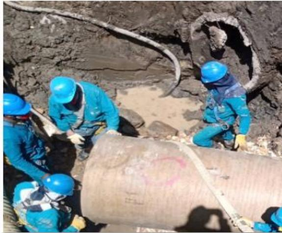
Nota. Instalación de tubería liviana dentro de Túnel Linner [40].
