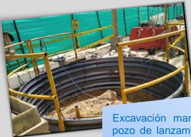
Excavación manual en zona de pozo de lanzamiento de diámetro 3.5 metros. Instalación de anillos en lamina circular de diámetro 3.5 metros para ascenso y descenso de personal, equipo y materiales.
