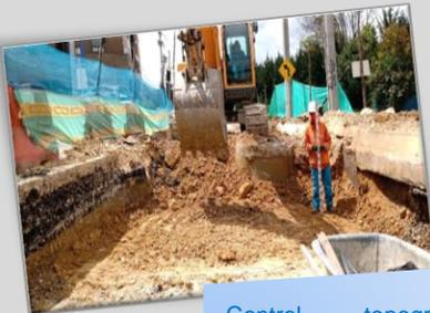
Control topográfico para conformación de estructura de vía, según Norma IDU.
