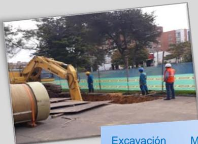
Excavación Mecánica con retroexcavadora hasta llegar a los niveles que indica los diseños.
