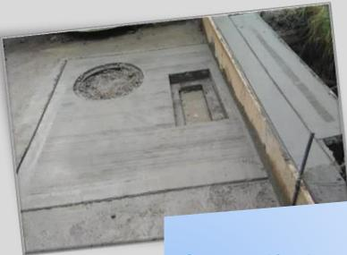
Construcción de sumideros en vía según norma EAAB-ESP.
