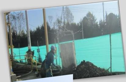
Extracción de material de excavación de pozos de lanzamiento y pozo de cierre con apoyo de equipo menor (malacates y trípodes) profundidades de trabajo entre 3.0 metros y 5.0 metros.
