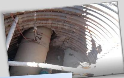
suministro e instalación de tubería GRP diámetro 40" en longitudes de 3.0 metros.
