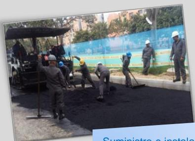
Suministro e instalación de mezcla asfáltica densa en caliente Md-19, utilizando pavimentadora.
