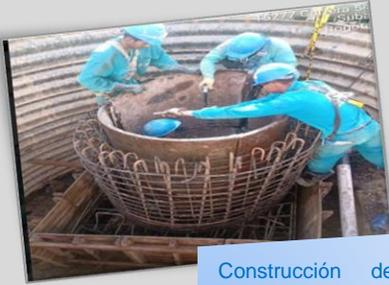
Construcción de cámara en concreto estructural en zona de pozo de lanzamiento.
