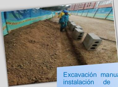
Excavación manual, suministro e instalación de sardinel A-10 afectados en sección de vía intervenido.
