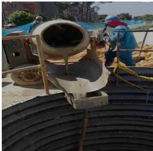
Nota. Retiro de material excavado y llenos con mortero por bomba
