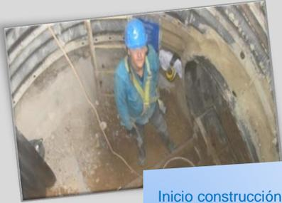
Inicio construcción de Túnel Linner d=60" con lamina metálica
