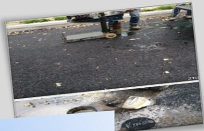
Se realiza toma de núcleos al pavimento instalado para verificación de espesores y demás resultados en laboratorio de suelos
