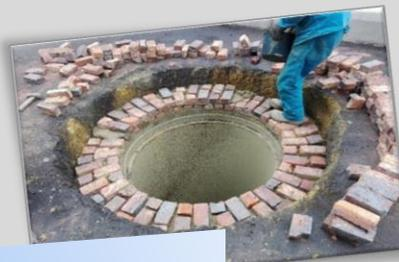
Construcción de viga perimetral a viga perimetral GRP para recibo de cargue superior D=1.70m
