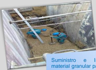
Suministro e Instalación de material granular para cimentación de tubería en espesor definido por diseño.
