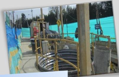
Excavación manual en zona de pozo de cierre de diámetro 3.0 metros.
