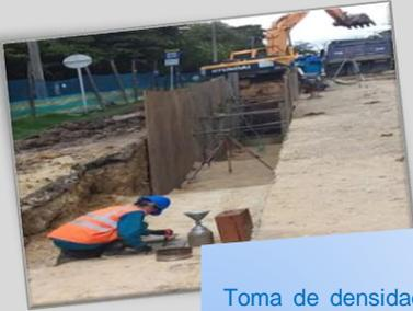
Toma de densidades del material granular, nivelación con topografía.
