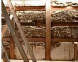
Figura 38. Consolidación exoesqueleto de madera, por Técnicas de refuerzo sísmico, (2018), (<http://informesdelaconstruccion.revistas.csic.es/index.php/informesdelaconstruccion/article/view/5902/6982>). (CC BY-NC-ND 2.5)
