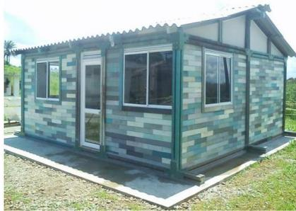
*Ilustración 59. Casa fabricada con bloque plástico*
